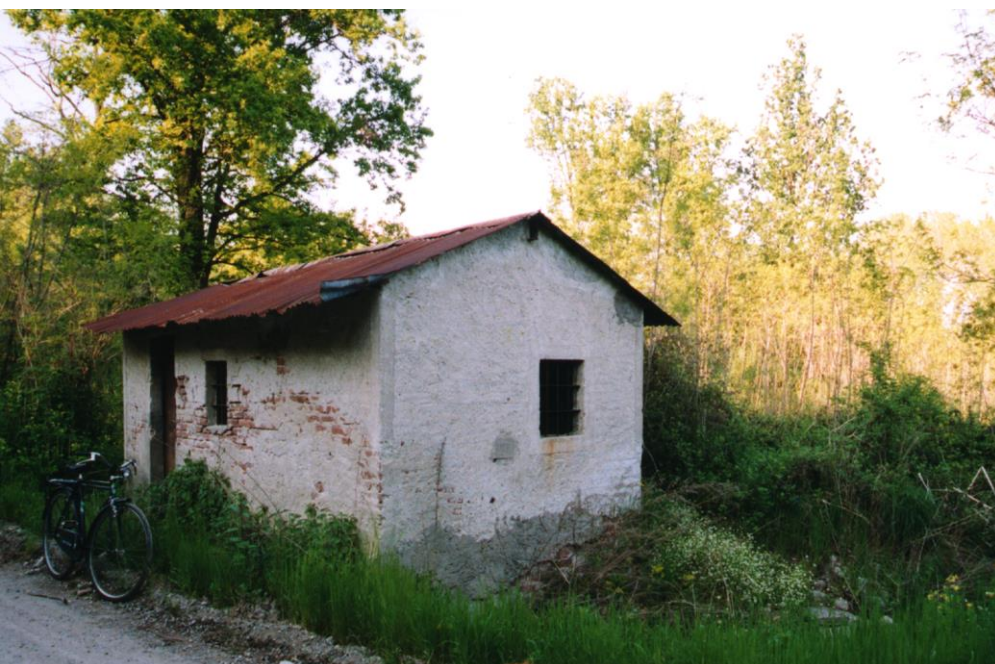
La casa dell'acqua dalla quale partiva la condotta del sistema antincendio di Carpignano
